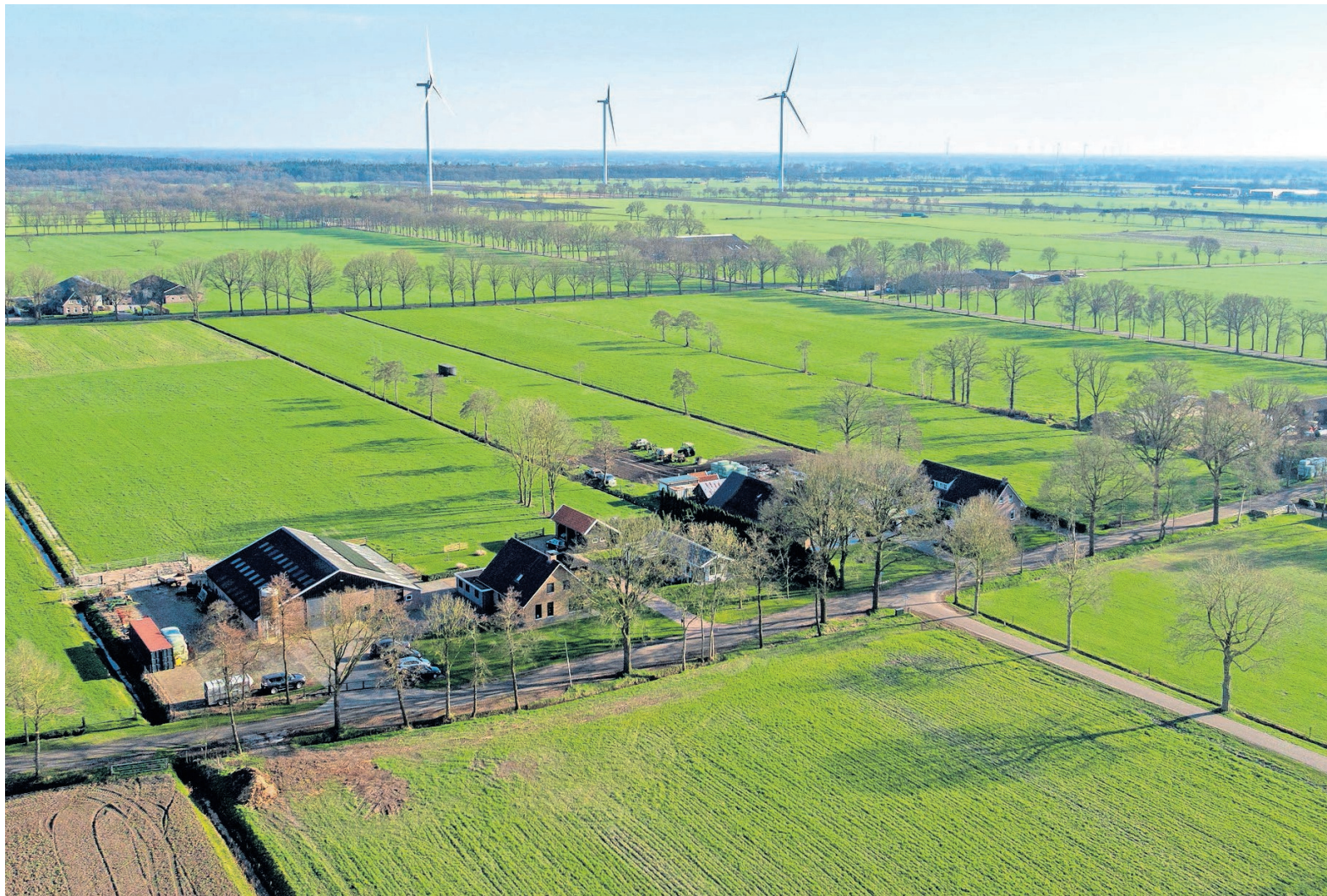
▲ De Zwarteveenweg in Staphorst met op de achtergrond Windpark Bovenwind. FOTO PEDRO SLUITER
